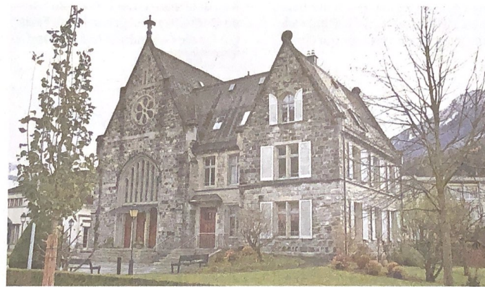
Die Dächer der Kirche und des Pfarrhauses in Brunnen müssen saniert werden: In den nächsten Monaten wird das Projekt angegangen. Bild: Josias Clavadetscher
