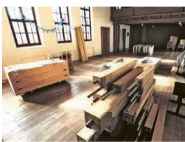
Die Sanierungen sind in vollem Gange.
