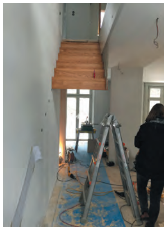
Treppe verbindet OG1 u. OG2
