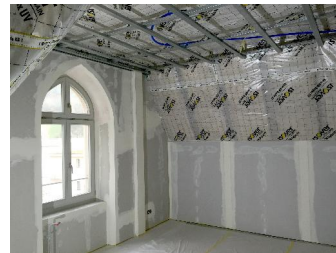
Die Decke wird isoliert
