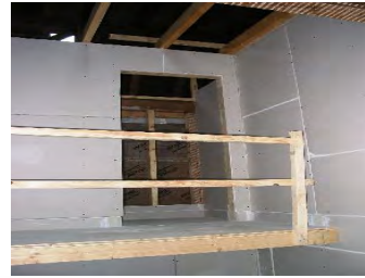
Das Treppenhaus wird brandfest gemacht
