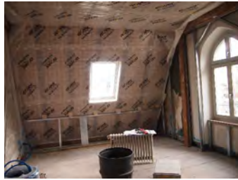
Das Dach wird isoliert
