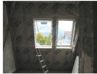
Neue Fenster bringen Licht ins dunkle Dachgeschoss
