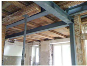
Die Statik wurde durch kräftige Eisenträger gesichert
